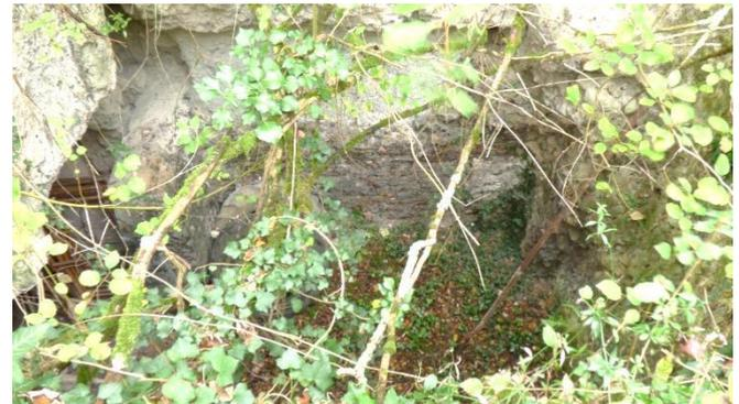
**Figure 97** La voute du four s'est effondrée, créant un trou béant dans le coteau. On peut apercevoir les vestiges du parement en briques (Photo prise depuis le coteau. A rapprocher du croquis de la figure précédente)
