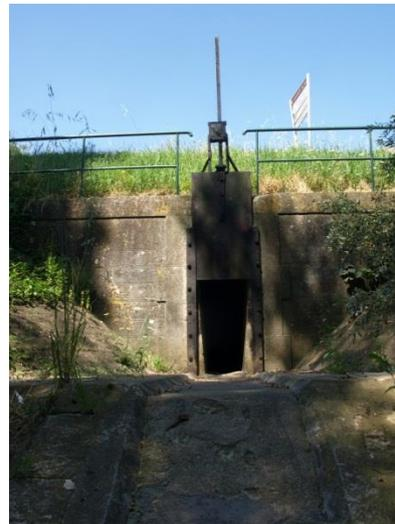
**Figure 42** Système anti refoulement, évitant qu'en cas de crue la Loire s'engouffre dans le réseau d'eau pluviale
