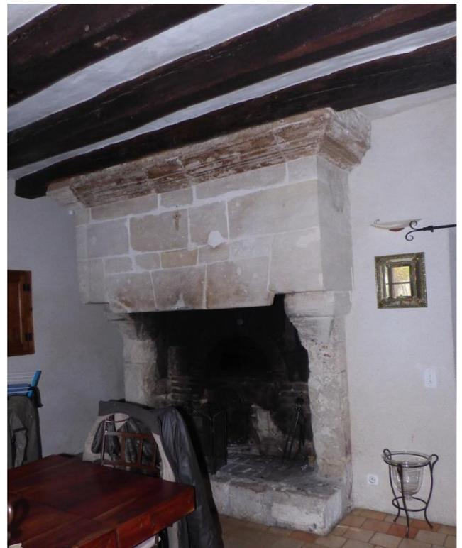
**Figure 110** La cheminée, avec à l'intérieur l'entrée d'un four à pain
