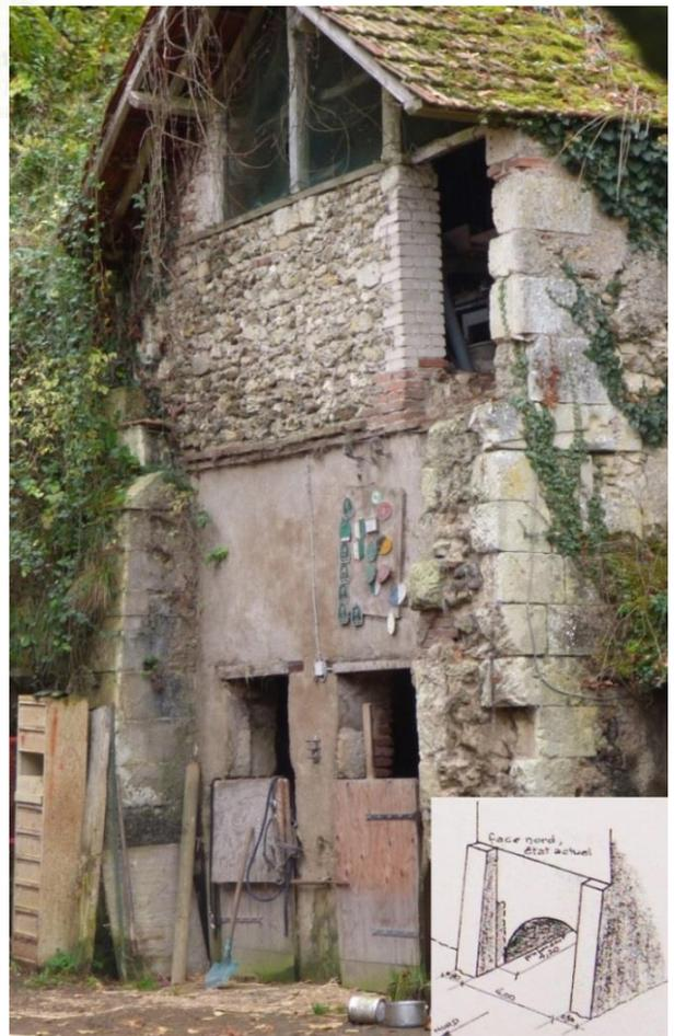
**Figure 88** Bâtiment où se situait le four à chaux; la façade a été modifiée faisant disparaître la voûte; les contreforts sont toujours là. L'encart donne une idée de la construction originale.
