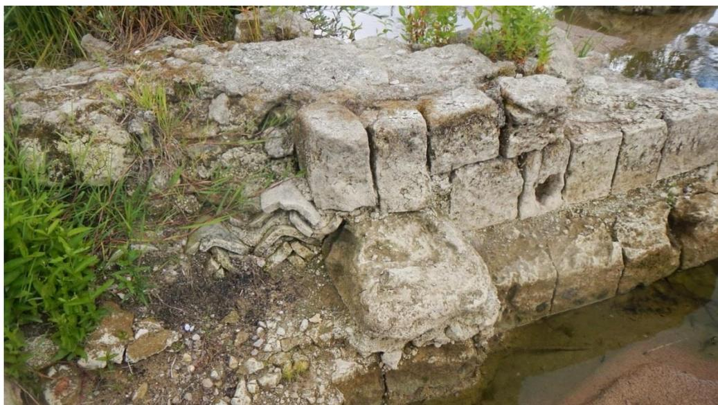
**Figure 68** Vue d'un des sous-ensembles : observer l'assemblage des pierres. Noter le réemploi de tuiles permettant d'obstruer une ouverture. Ces tuiles pourraient permettre d'estimer une datation de l'ouvrage : elles ressemblent à des imbrex gallo-romaines. (Photo R.Pezzani du 30.06.2014)
