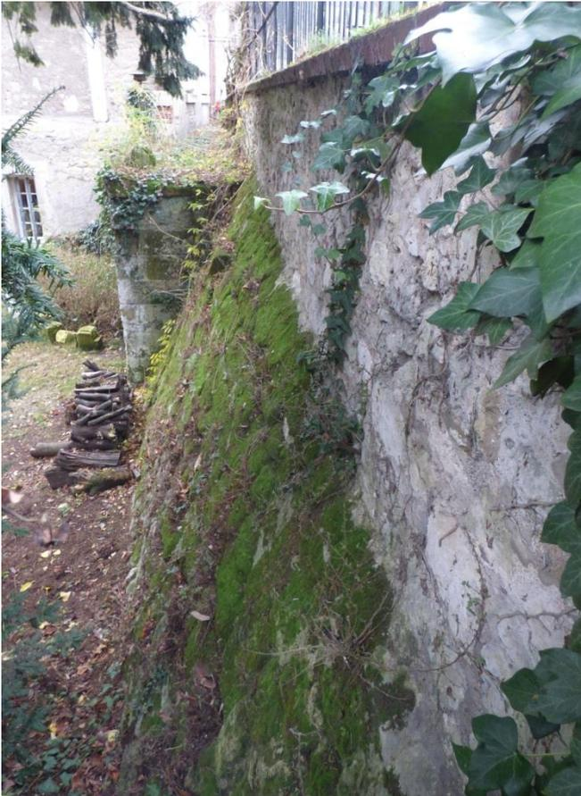
**Figure 146** Le pied du moulin se trouve trois mètres en dessous de la rue (en haut à droite). Le flan en pente du mur de soutènement de la rue s'apparente à un perré ; on peut penser que la Loire venait baigner le bas de ce mur, et que le moulin avait les pieds dans l'eau !
