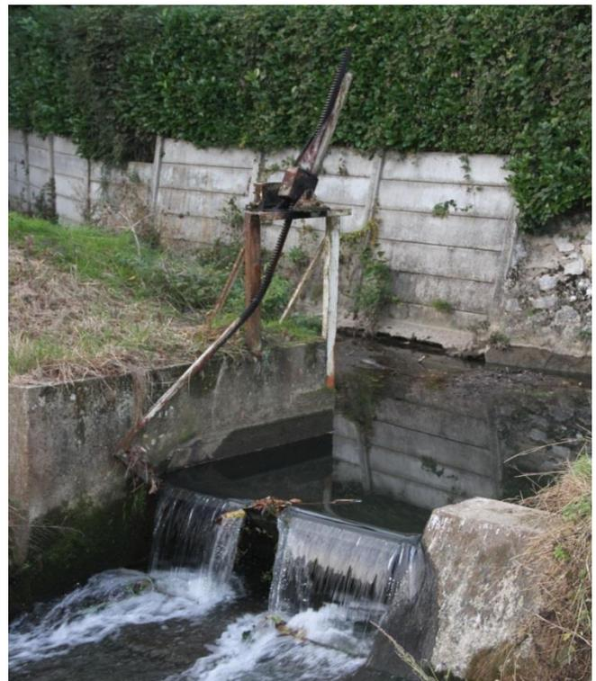
Figure 145 Déversoir permettant la régulation de l'eau du bief du moulin. (Proche de la rue des Clouet)
