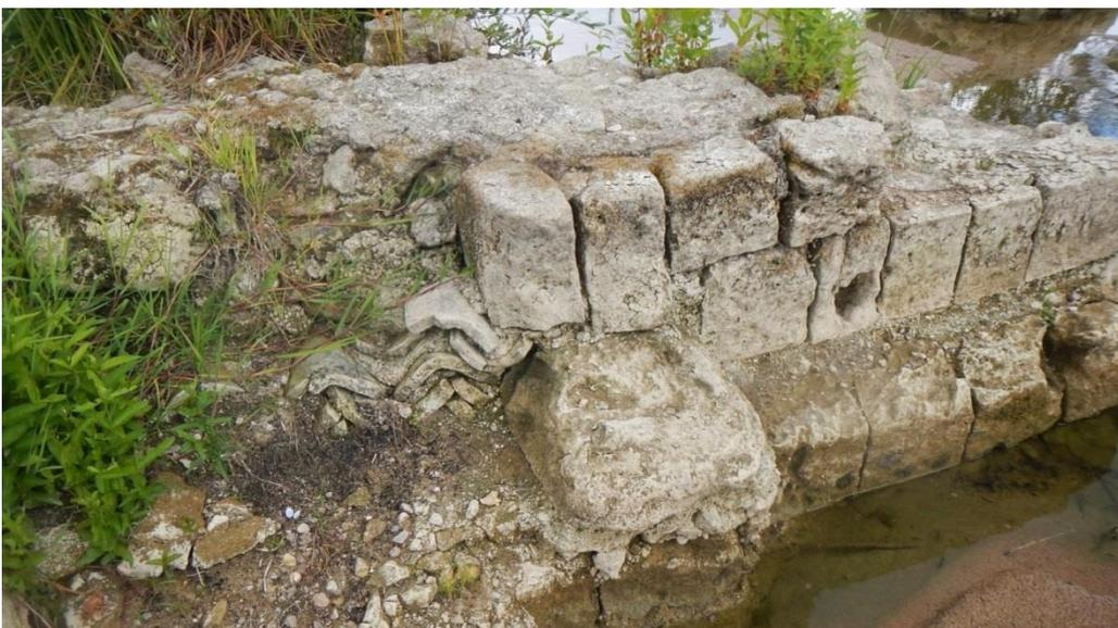
**Figure 68** Vue d'un des sous-ensembles : observer l'assemblage des pierres. Noter le réemploi de tuiles permettant
