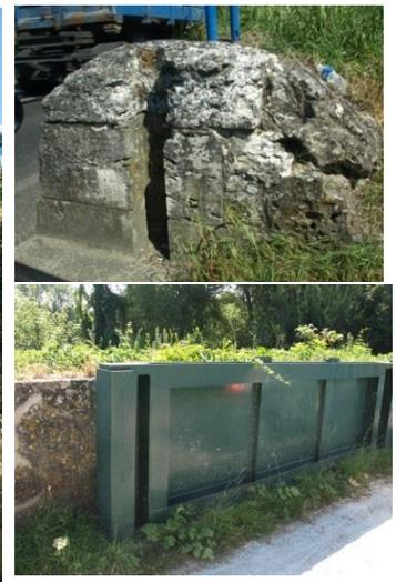
**Figure 43** Encoche dans la digue (haut) et « les bouchures » (bas) permettant d'obstruer les accès, et la Nationale 152 !
