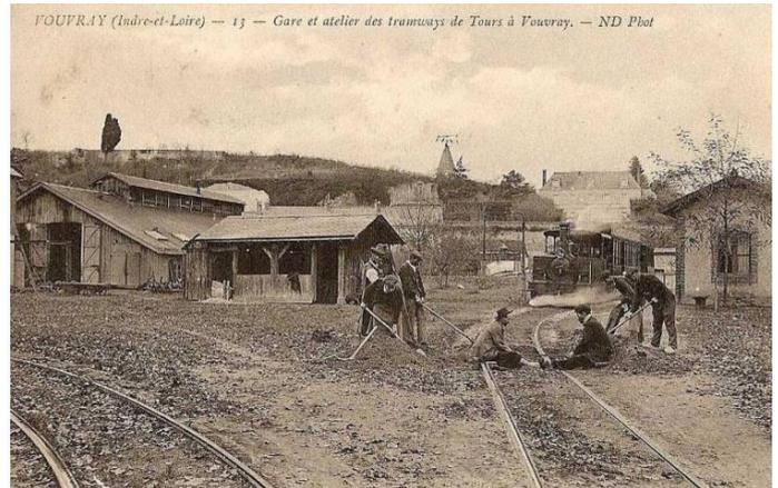
Figure 228. Pose des rails du tramway entre Tours et Vouvray
