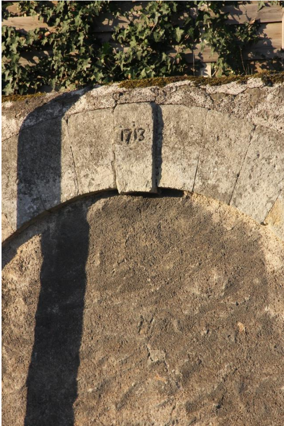
Figure 76 La date de 1713 est gravée sur le plein cintre d'une porte murée.
