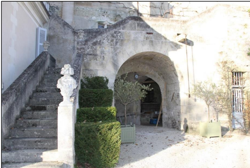
Figure 91. Escalier donnant accès aux différentes terrasses et paliers
