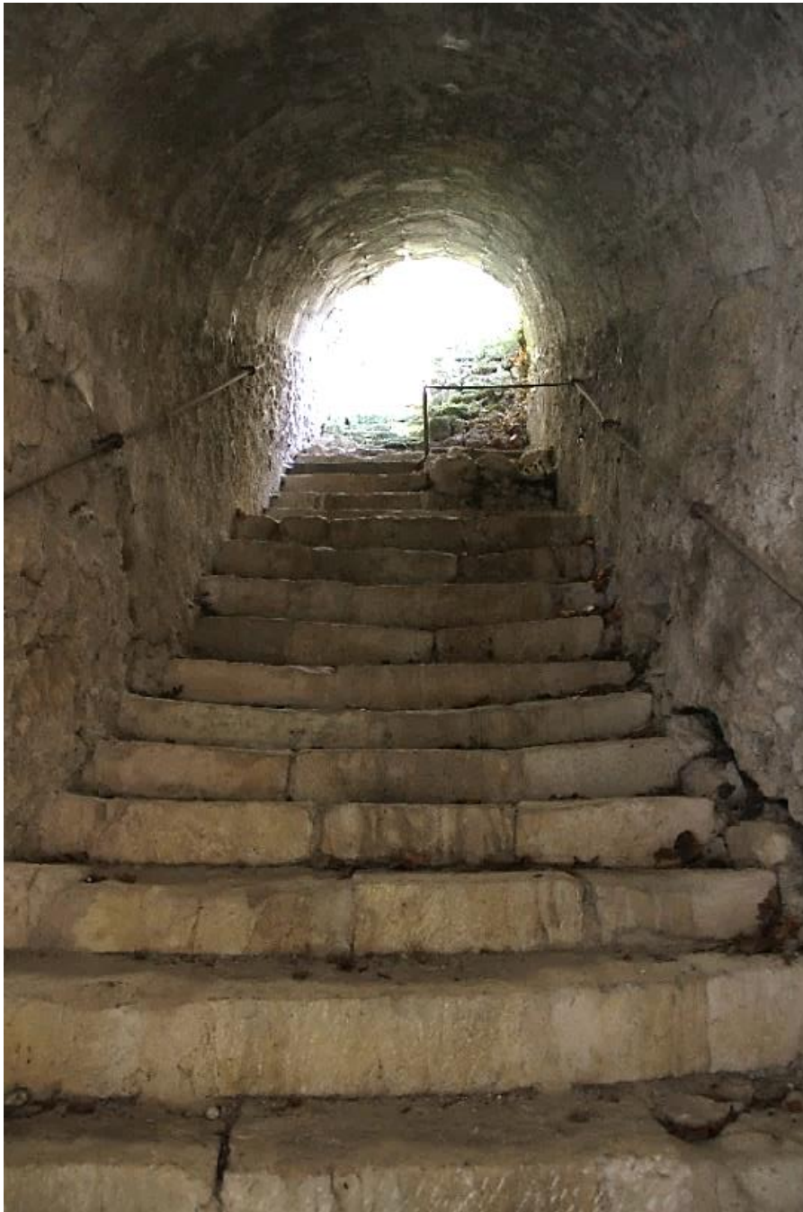
Figure 70 un escalier taillé dans le roc permet d'atteindre le haut du coteau
