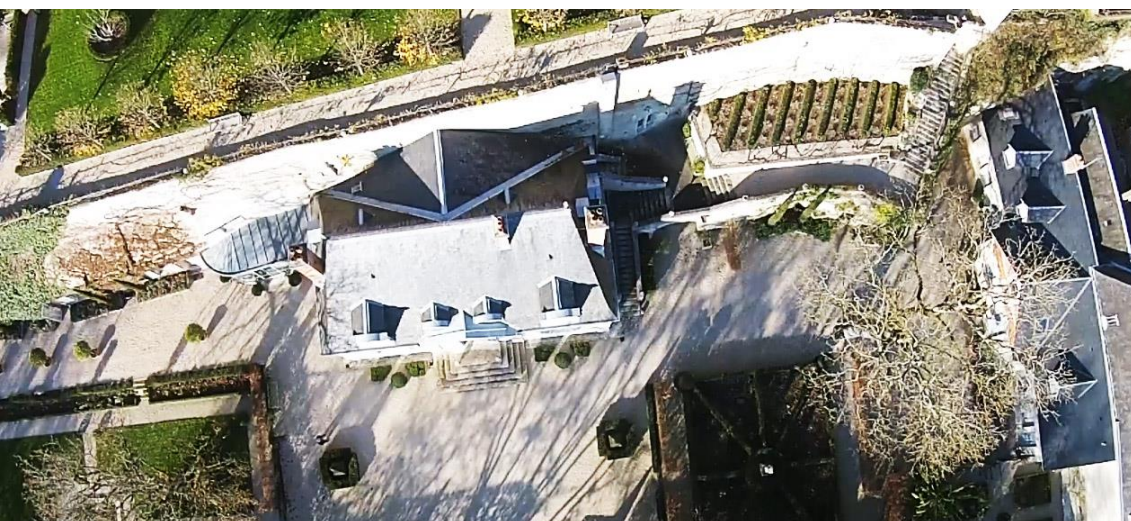
Figure 86 Le rocher à l'arrière de la maison a été consolidé, la toiture modifiée...
