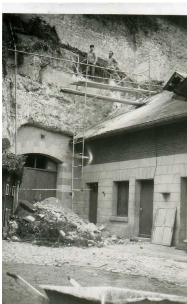
Figure 151. Il fallut entreprendre un renforcement du coteau après l'effondrement de janvier 1961 (photo famille Brosseau).
