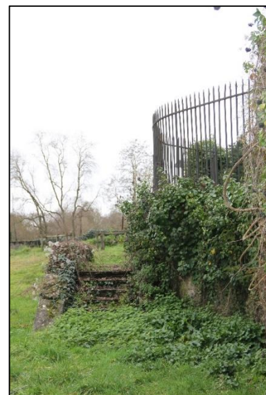
Figure 93. La grille au sud de la levée est toujours là au-dessus du mur.
