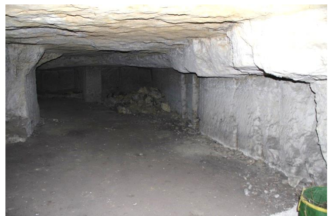
Figure 67 Perrières des Basses-Rivières. On peut parfaitement observer la veine de pierre dure exploitée par les "Perreyeurs"
