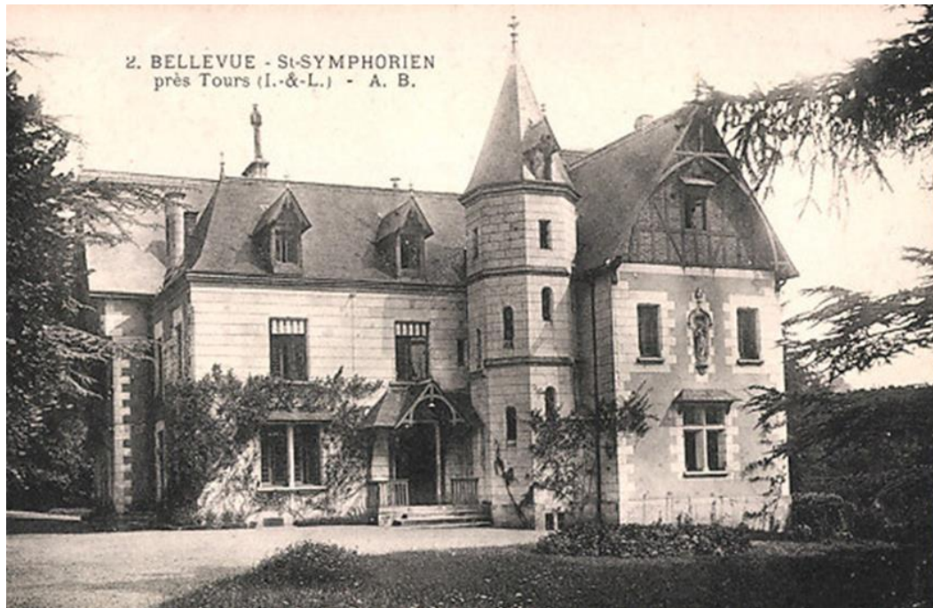
Figure 101 Bellevue : propriété des époux Fouquet, à St Symphorien, quartier des Cordeliers, au voisinage de la Tranchée
