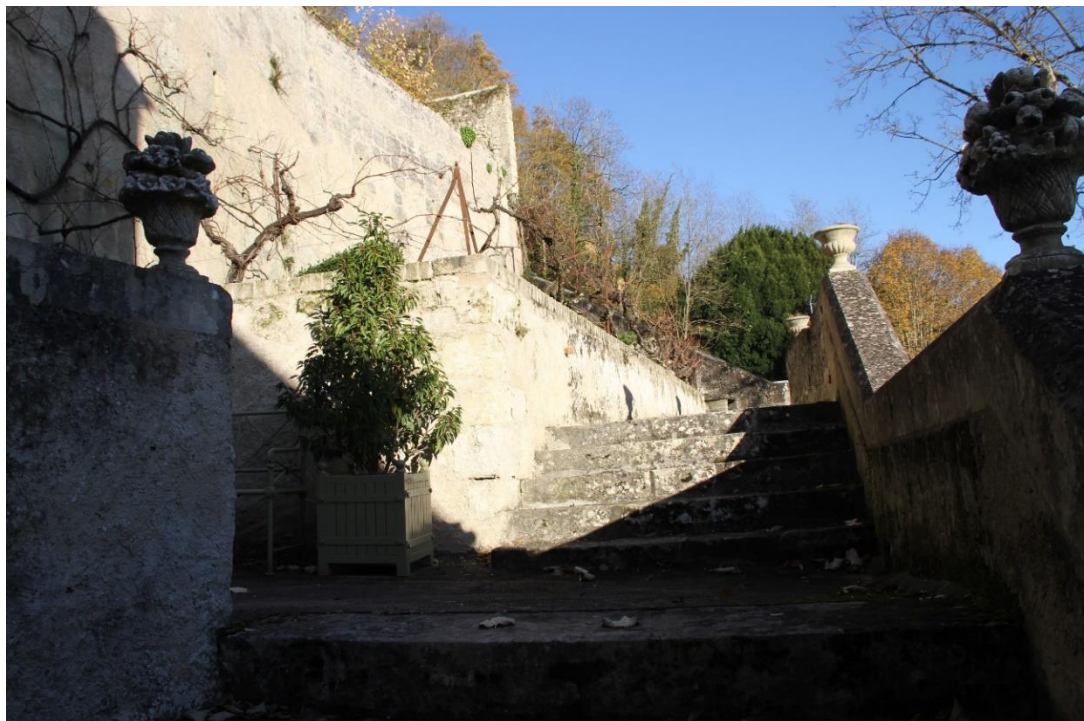
Figure 162. Escalier donnant accès aux différentes terrasses.
