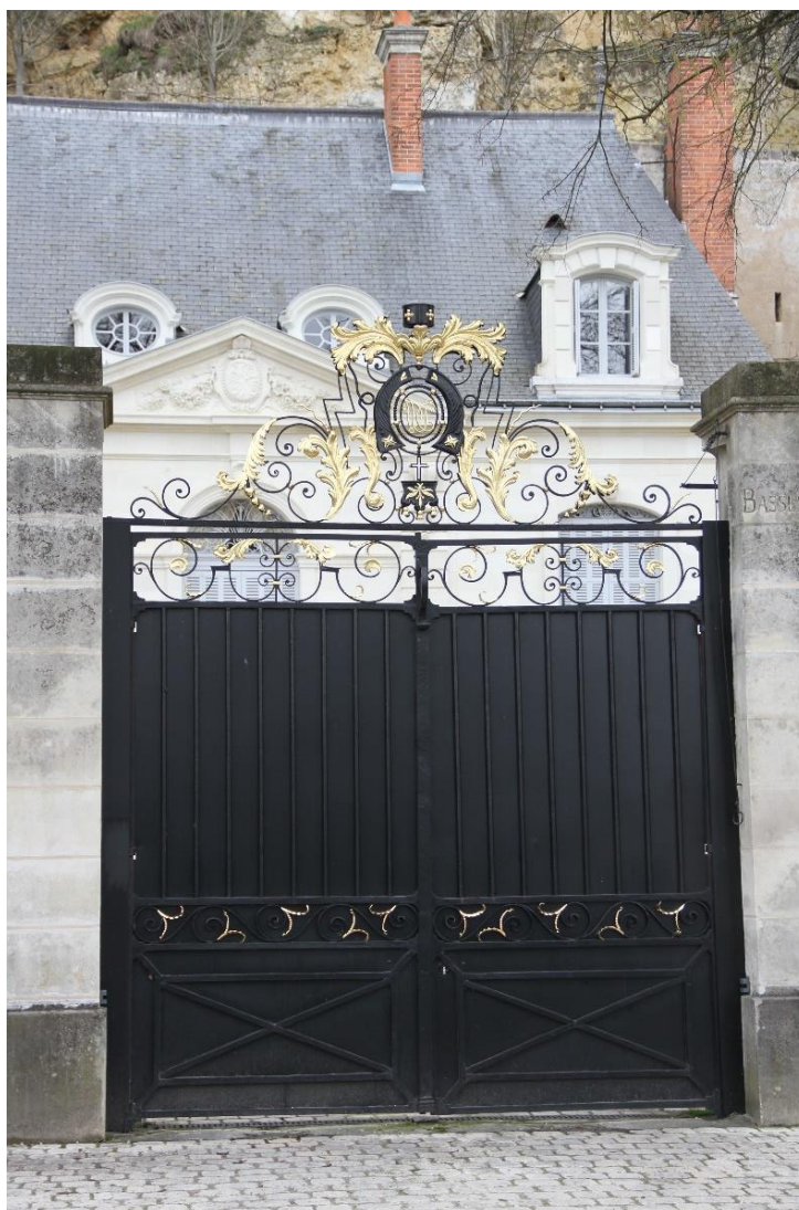
Figure 166. La grille restaurée du Manoir des Basses-Rivières.
