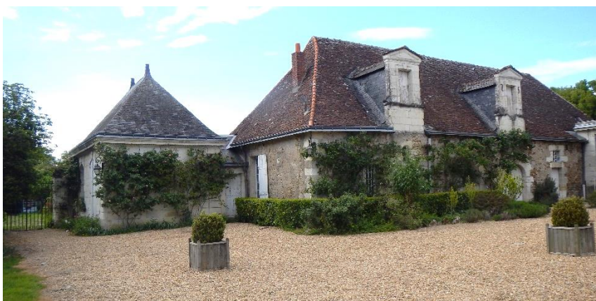
Figure 156 A l'Est et à l'Ouest de la cour, les communs (ici, côté Ouest) ; on aperçoit sur la droite la porte cintrée donnant accès à l'ancien pressoir.
