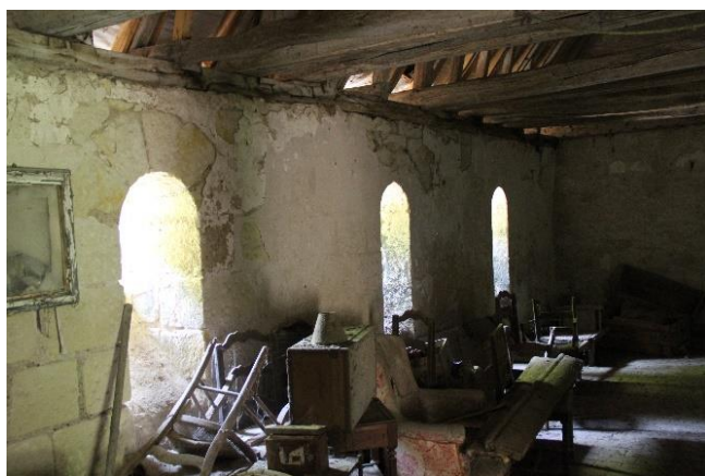
Figure 78. Le niveau supérieur ; la charpente d'origine avec ses entrails, sol en carreaux de terre cuite.
