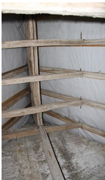
Figure 81. Charpente (2015) avant travaux
