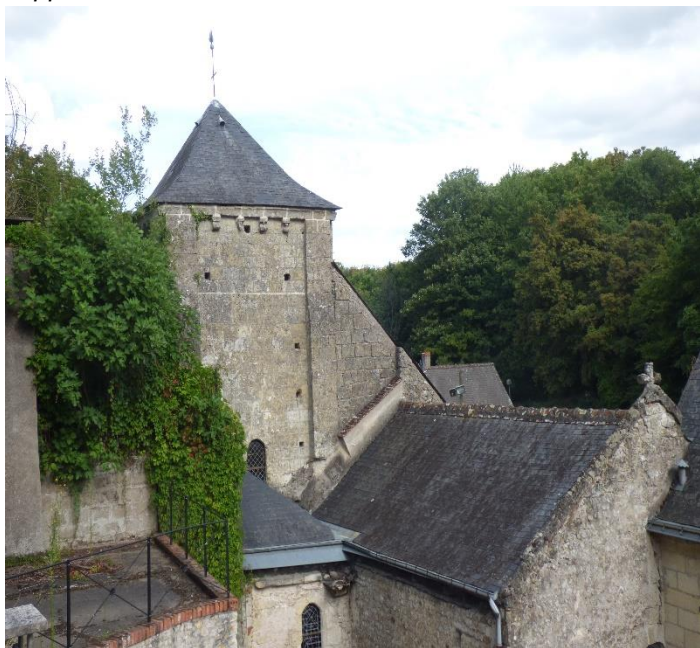
Figure 18 Au Nord Est le clocher; on peut constater la modification de la toiture du chœur, maintenant à un seul pan, et plus haute que celle de la nef, qui n'est pas modifiée.
