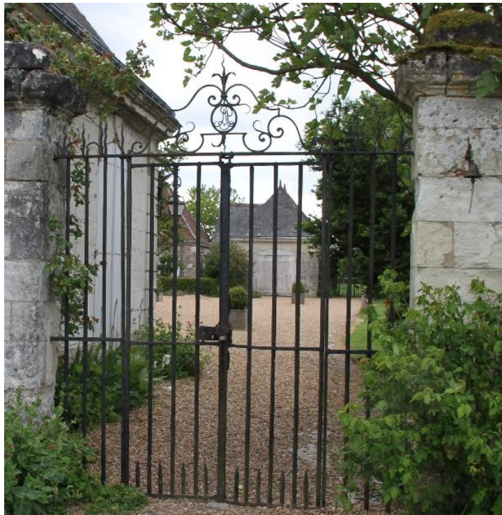
Figure 181. Le portail latéral avec, sur son fronton, les trois initiales P L A
