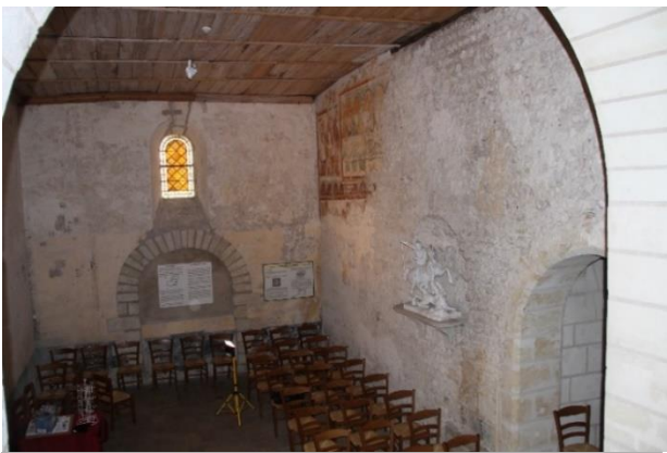
Figure 29 A l'intérieur de la chapelle on distingue parfaitement la trace de l'ancien porche aujourd'hui muré
