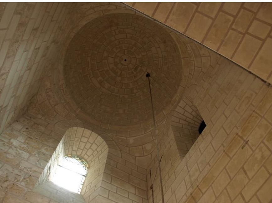
Figure 20. Intérieur du clocher avec sa coupole de pierre. Remarque importante : noter la présence d'une baie non éclairée ; elle donne sous la charpente du chœur, et permet d'accéder dans les sous-pentes. Cela ne justifie pas son existence ; elle est identique à la baie Est. Initialement, cette baie aveugle donnait au Sud, vers l'extérieur, apportant lumière et clarté. Sa présence démontre que le choix de la forme actuelle de la charpente du chœur fut tardif et décidé après l'érection du clocher.
