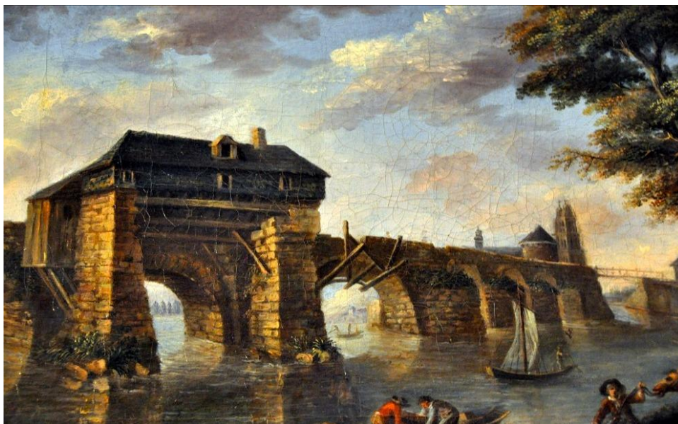
Figure 92. Le pont de Tours (pont de Eudes) en perspective la cathédrale et le château de Tours avec sa Tour de Guise.
