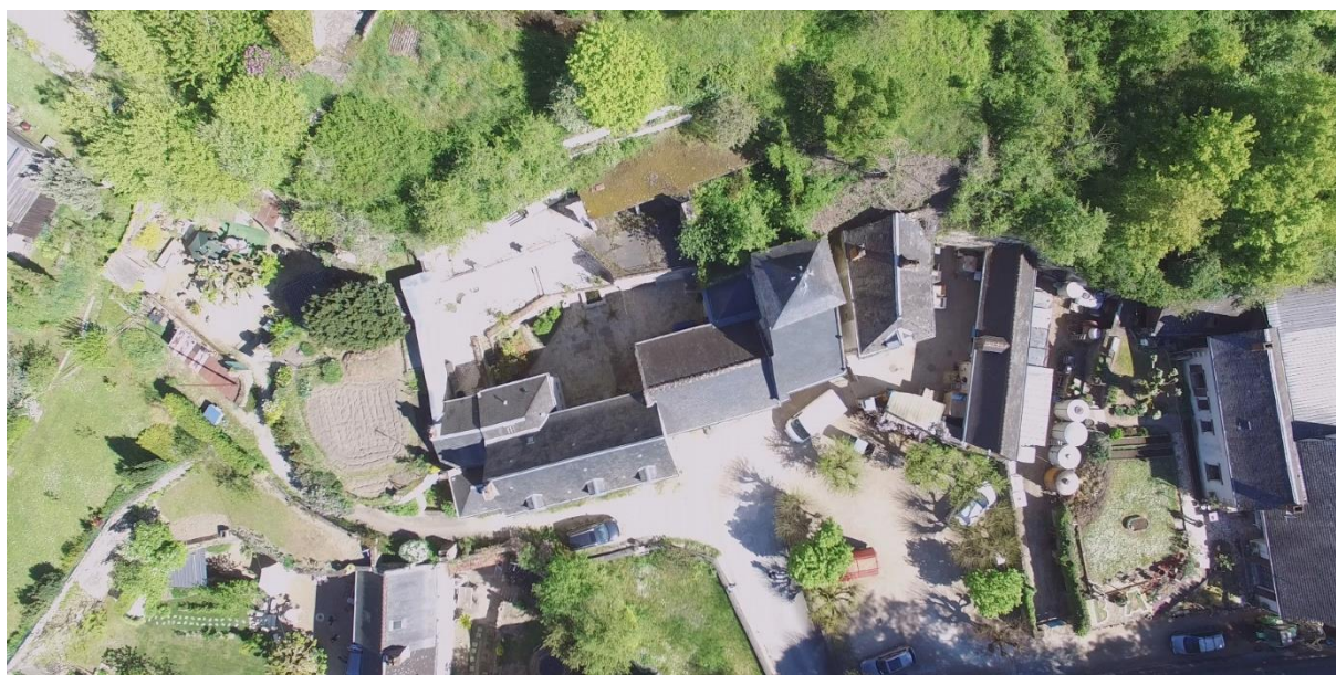
Figure 33. La chapelle et l'ancien presbytère : vue aérienne.
