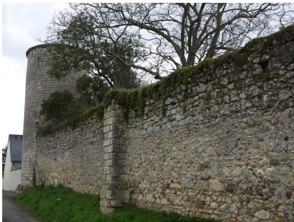
Figure 186. La tour du hibou aujourd'hui. On aperçoit le mur d'enceinte de Marmoutier que la construction de l'autoroute A10 a partiellement détruit
