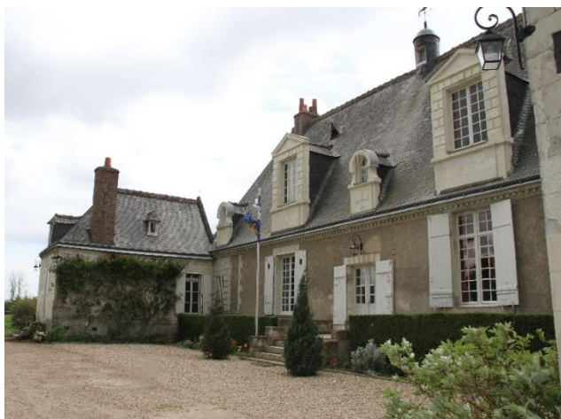
Figure 153 La façade Nord.
