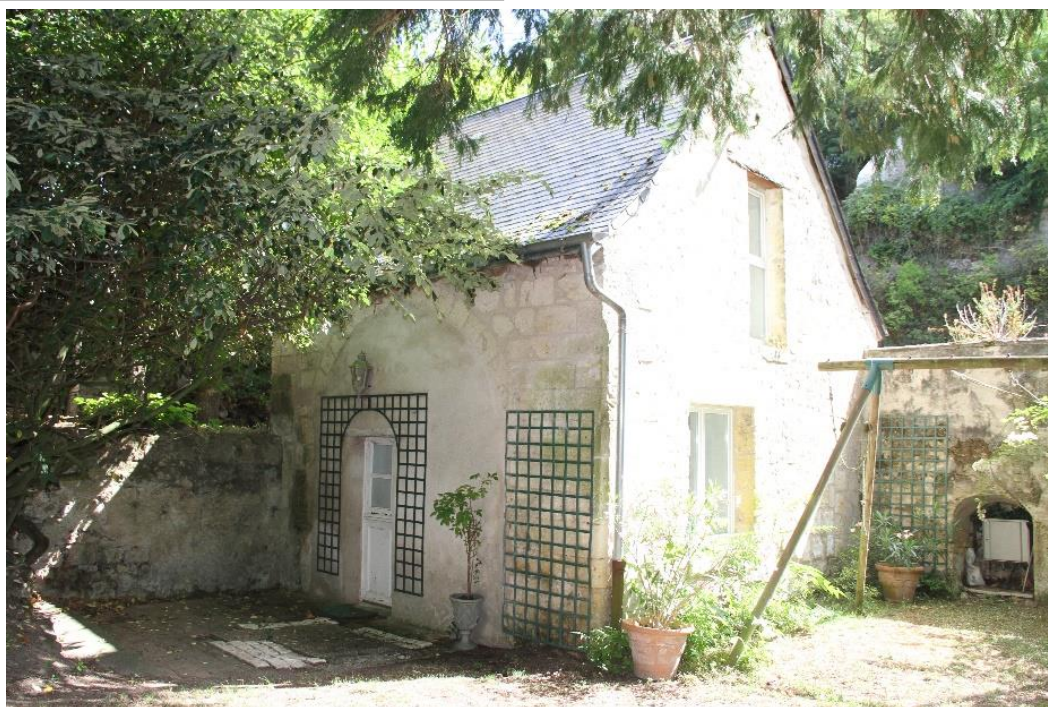
Figure 52. L'ancienne maison du closier. La maisonnette a été fortement remaniée ; remarquer l'ouverture cintrée murée coté propriété. Côté rue le mur garde trace de l'ancienne devanture d'une boutique.
