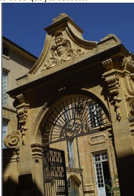
Figure 106. Hôtel de Boyer d'Eguilles à Aix en Provence
