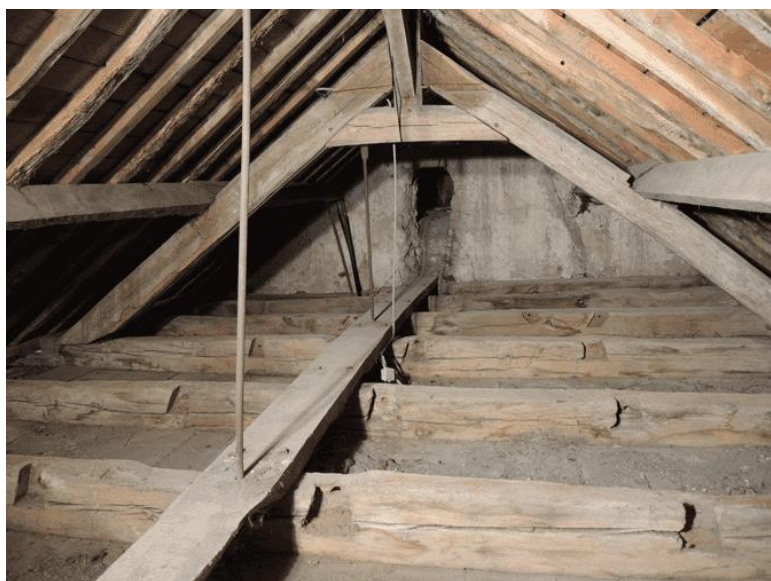
Figure 40. La charpente de la nef de la chapelle Saint-Georges.
