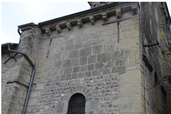
Figure 17 Le passage de « petit appareil », en « moyen appareil » avec les moellons plus importants, renseigne sur les modifications apportées sur le haut du chœur.
