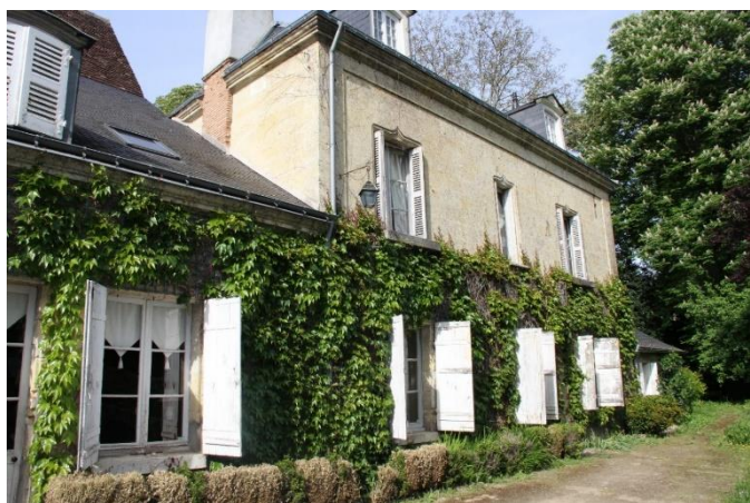
85 La maison accolée à la chapelle en 2015 (avant travaux)
