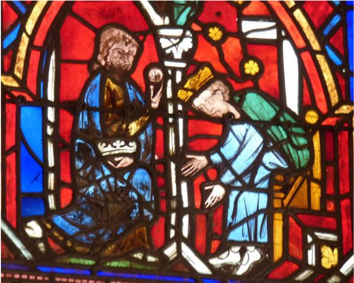
Figure 24 Registre inférieur du vitrail du XIII e siècle. (On voit que les plombs sont saillants vers l'intérieur de la chapelle, alors qu'ils devraient l'être vers l'extérieur, cela démontrant son montage inversé)
