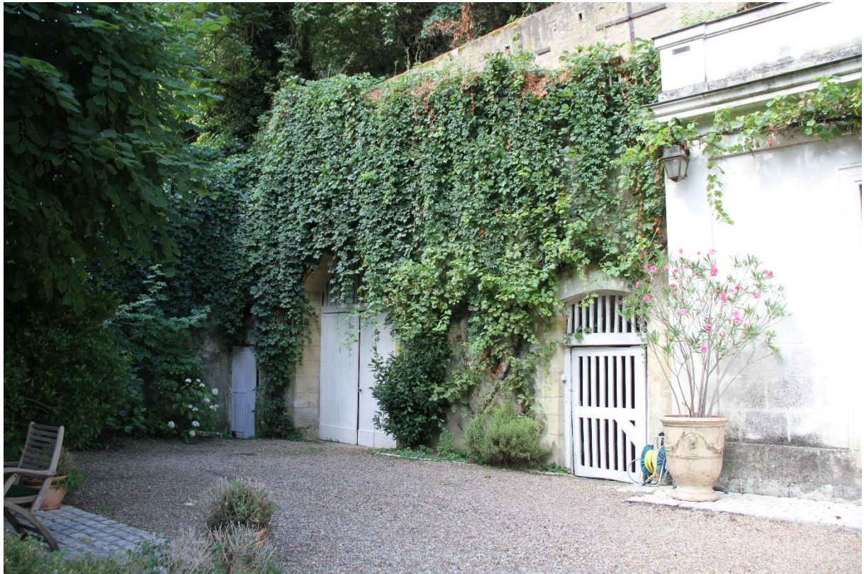
Figure 49. A l'ouest, le long du coteau, les entrées de deux caves
