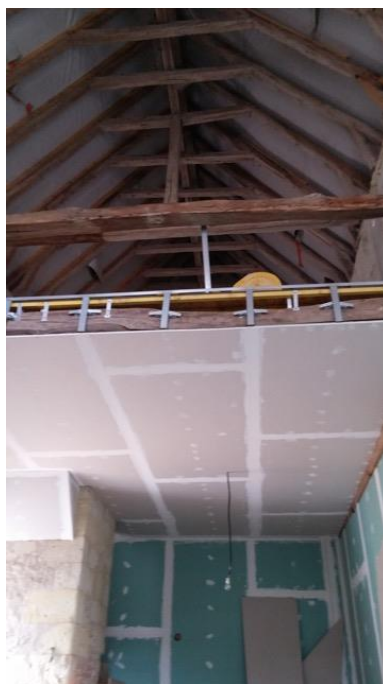
Figure 84. L'intérieur en cours de travaux ; la majorité des entrails a été coupée
