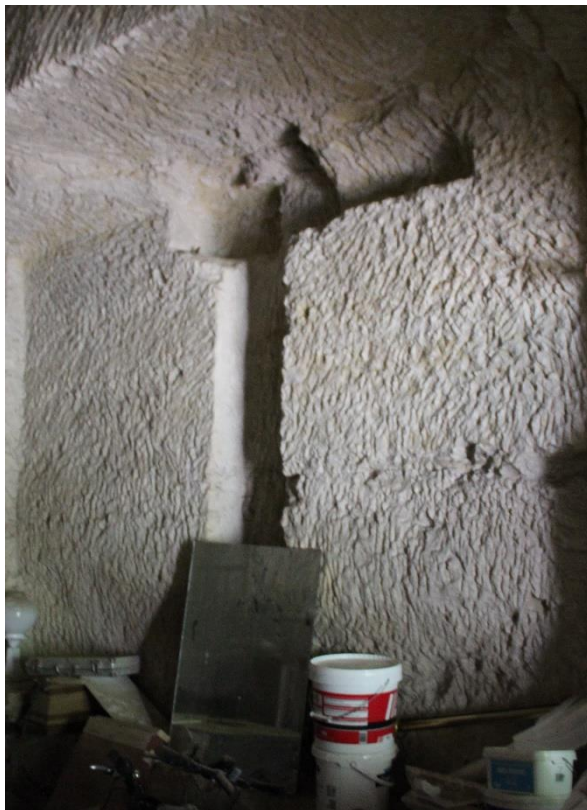
Figure 48. Dans la seconde cave, la paroi porte la trace de l'ancienne présence d'un pressoir de taille importante
