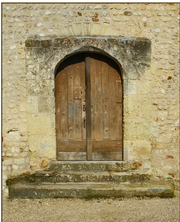
Figure 45 Au-dessus de la porte d'entrée actuelle on aperçoit les claveaux rectangulaires formant le plein cintre de l'ancienne ouverture; elle était plus étroite et permettait d'accéder directement au cimetière.
