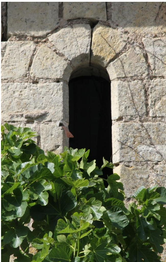
Figure 77. Baie en forme de meurtrière (extérieur)
